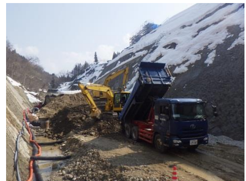
減勢工進入路整備
