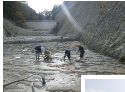
岩盤清掃状況
