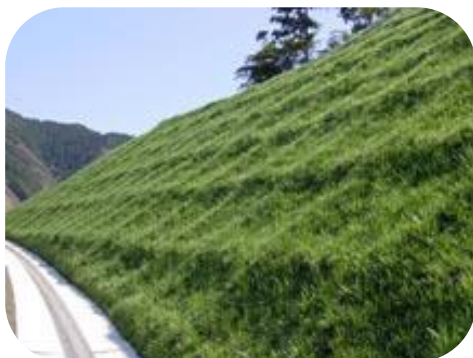
(全面緑化法面の他現場での施工事例)
