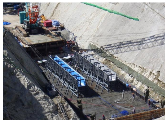
常用洪水吐きの鋼製水路の据付の様子
