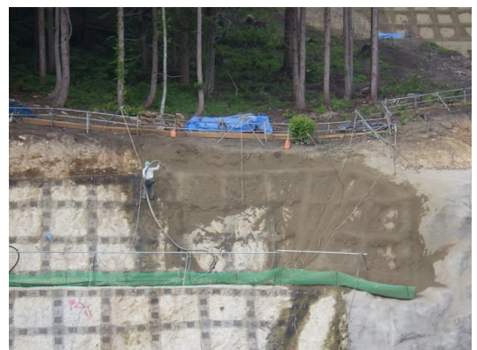
法面保護工事 改良土吹付の様子
