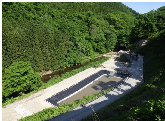
写真：貯留池 (濁水を一時溜めておきます)
