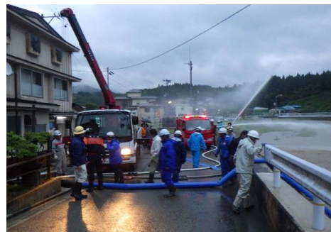
排水作業の様子
