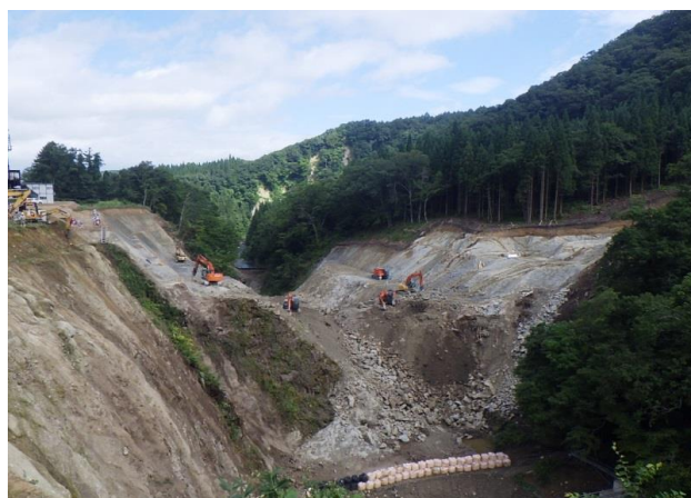
現在の基礎掘削状況
