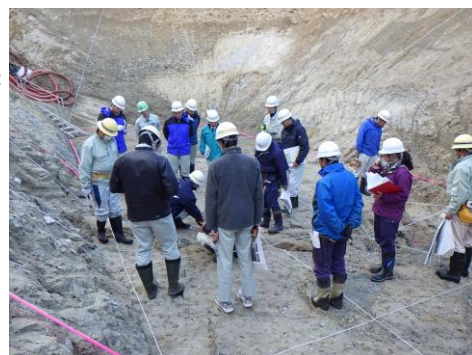
(地盤検査状況)
