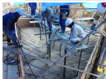
コンクリート打設の状況
