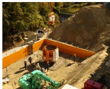
← 初打設の様子
