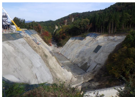
基礎掘削完了の様子
