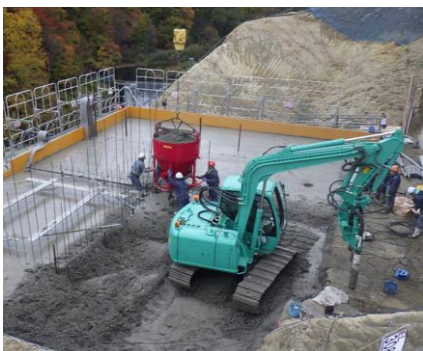
ダム本体打設の様子
