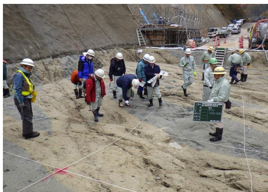
基礎地盤検査の様子(現地確認)
