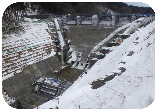
ダムサイト下流側より望む(H31.3.25)
