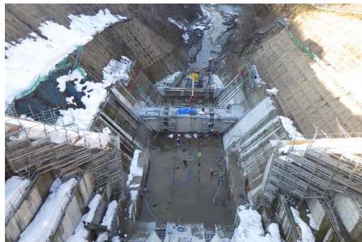
ダムサイト下流側(減勢工完了)
