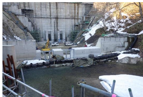
ダムサイト下流側(減勢工完了)
