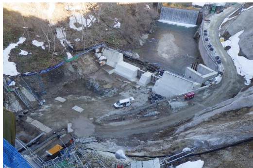
ダムサイト上流側(上流2次仮締切改良完了)
