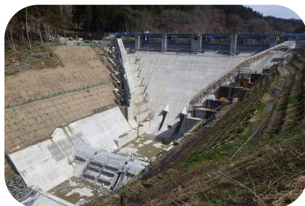
ダムサイト下流側より望む(H31.4.20)
