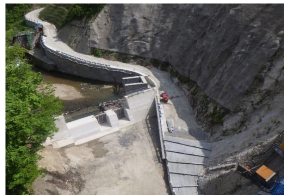
ダムサイト上流側(R1.5.19)
